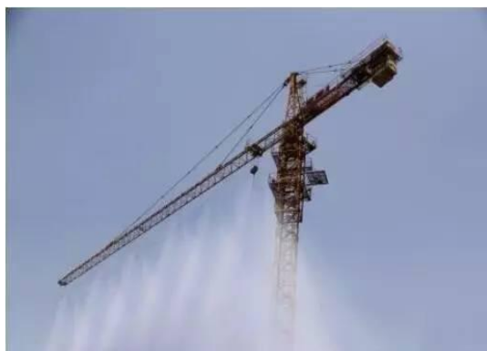
高空塔吊除尘
