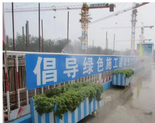
施工区域道路喷淋
