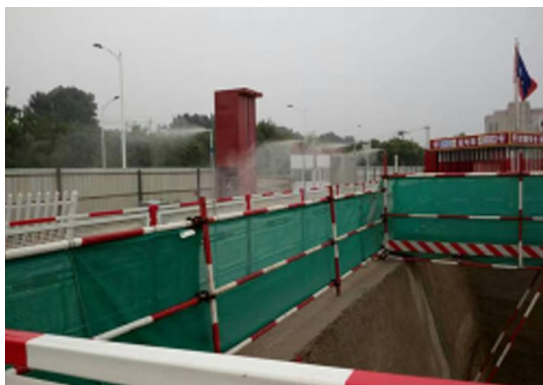
工地基坑喷雾除尘
